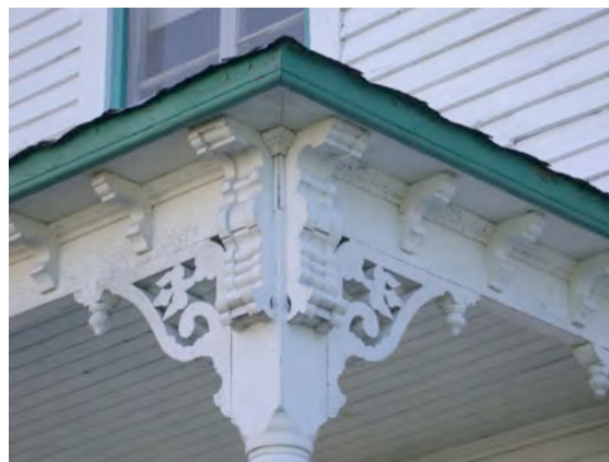
Saint-Barnabé. Aisseliers ornementés au sommet d'une colonne et consoles en bordure de l'auvent. Saint-Barnabé maisonB (11).jpg
