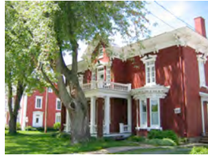
Maison en briques rouges de la rue Sainte-Anne. IMG_7071.jpg
