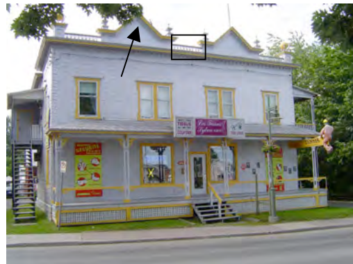
Avenue Saint-Laurent, Louiseville. Une maison à toit plat, dont le rebord de la toiture est orné de frontons (flèche) et d'un garde-corps ouvragé (rectangle). DSC01629.jpg
