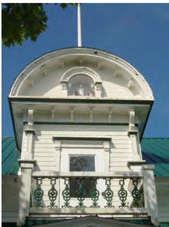
Lucarne-balcon particulièrement élaborée au 1990, rang de la Grande-Carrière à Sainte-Ursule. Une niche est logée au centre du fronton arrondi. Le garde-corps est constitué d'éléments en fonte moulée. DSC01032.jpg
