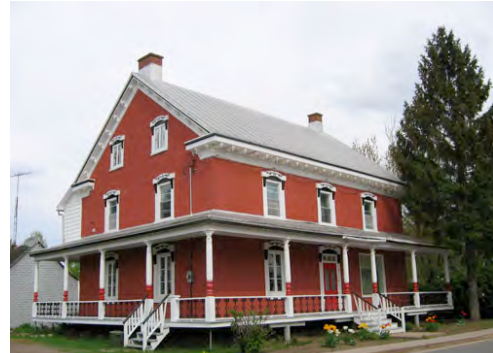
Un parement de brique sur un immeuble de type Nouvelle-Angleterre, très caractéristique de la MRC. Saint-Sévère maisonmichelbellefleur(2).jpg
