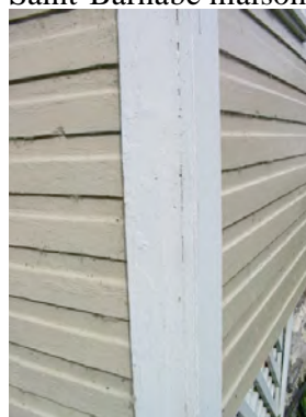
Yamachiche. Plancher cornière. Cet élément est une garniture de rive qui se situe à la jonction de deux murs. 700sta-h.jpg
