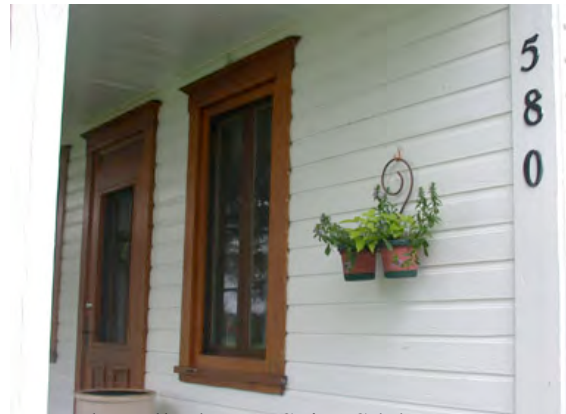
Rang de Bellechasse, Saint-Sévère. Un parement de planche à feuillure. Maison Lavigne (5).jpg
