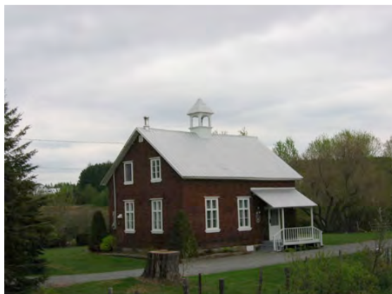
Ancienne école de rang, route 349, Saint-Alexis-des-Monts. IMG_6899.jpg
