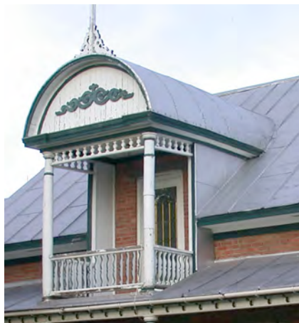
Au 280, chemin de la Grande-Rivière, Saint-Barnabé, une lucarne-balcon dont le toit est de forme demi-cylindrique. On remarque sur le front l'applique découpée, très répandue dans la MRC de Maskinongé Saint-Barnabé Maison K (1).jpg
