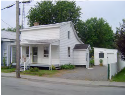
Maison de Louiseville dont la volumétrie n'est plus conforme à celle d'origine : les deux versants du toit sont asymétriques et le versant avant a été rehaussé. DSC02370.jpg
