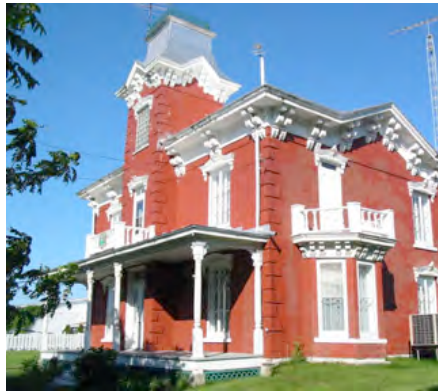
Le 150, rue Gérin-Lajoie à Yamachiche est doté d'une tour comparable à celle du 580, rang Lamy. L'immeuble a été érigé par la famille Héroux. gela-c.jpg
