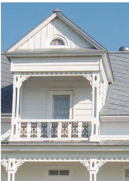
Lucarne-balcon au 215, route du Pied-de-la-Côte à Maskinongé. Le devant de la lucarne est coiffé d'un fronton. Le garde-corps est constitué d'éléments en fonte moulée. On remarquera sous le balcon les aisseliers (cercle) au sommet des colonnes.
