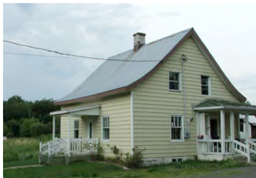
Maison de conception québécoise de Saint-Étienne-des-Grès, recouverte d'un matériau moderne et ayant perdu ses garnitures de rive. DSCF2826.jpg
