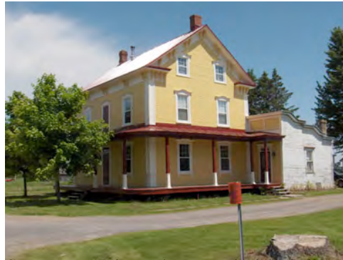
Sur cette maison du rang de la Rivière-Sud-Est de Maskinongé, on a conservé les chambranles malgré la mise en place de fenêtres à guillotine modernes. HPIM0466.jpg
