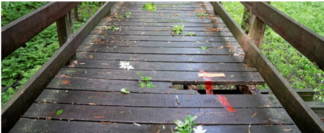
Passerelle de la Pointe-à-Caron à Louiseville - Photo Le Nouvelliste
